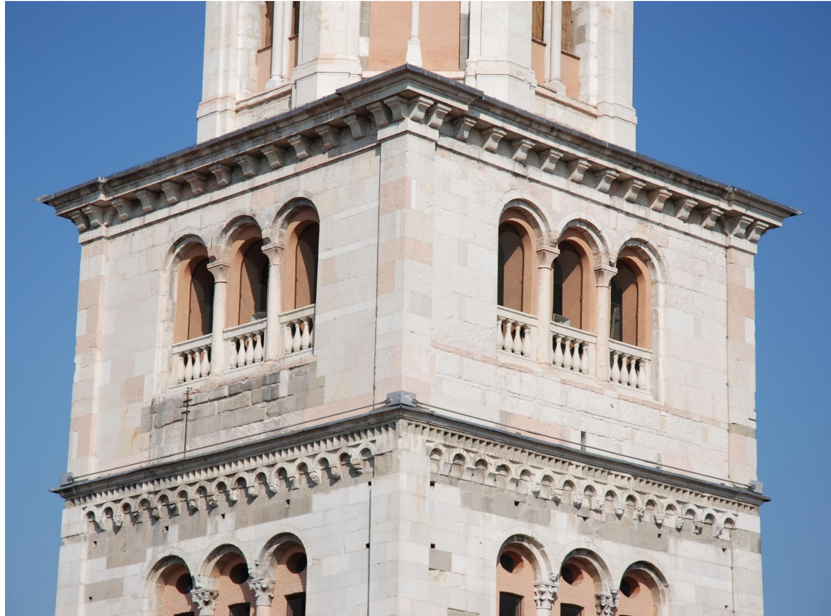
Cerchiatura del piano campanario
